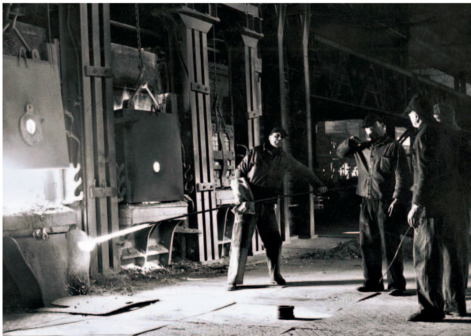
▲ Prelevamento di un campione d'acciaio liquido dal forno Martin Siemens. Per ogni colata erano necessarie circa otto ore. (AFI Press, 1955-1956. © Dalmine SpA)
