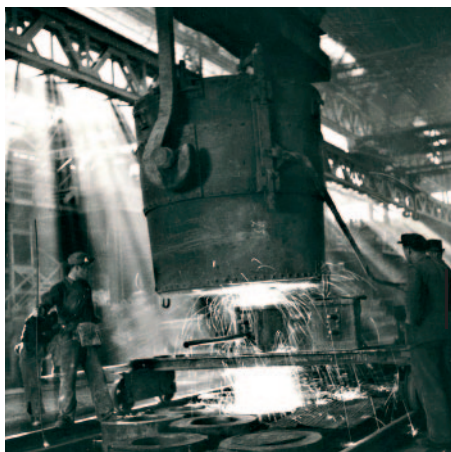
▲ Prelevamento di un campione d'acciaio liquido dal forno Martin Siemens. Per ogni colata erano necessarie circa otto ore. (AFI Press, 1955-1956. © Dalmine SpA)
